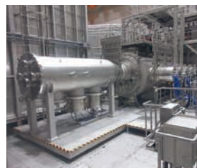
真空排気装置の設計・設置
