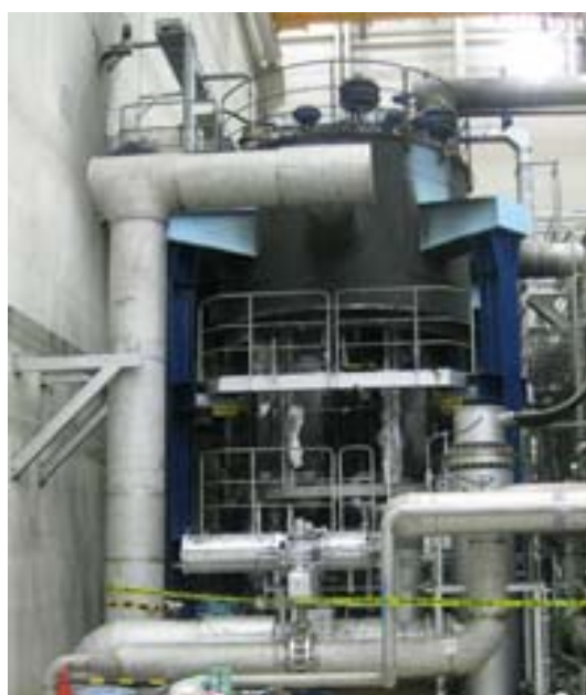
図4 火災を起こしたコールドボックスの近景。外筒に黒いススが付いている。
