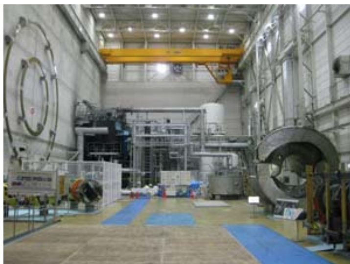
図3 火災後の液化機室。左奥の黒くなった部分（一部、元の塗装色である水色が残っている）が火災を起こしたコールドボックス。火災は局所的で、コールドボックス以外の機器や建物には被害はなかった。（手前は展示用スペース）
