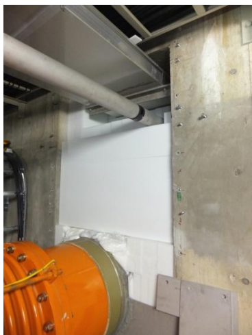
貫通口閉止処理
