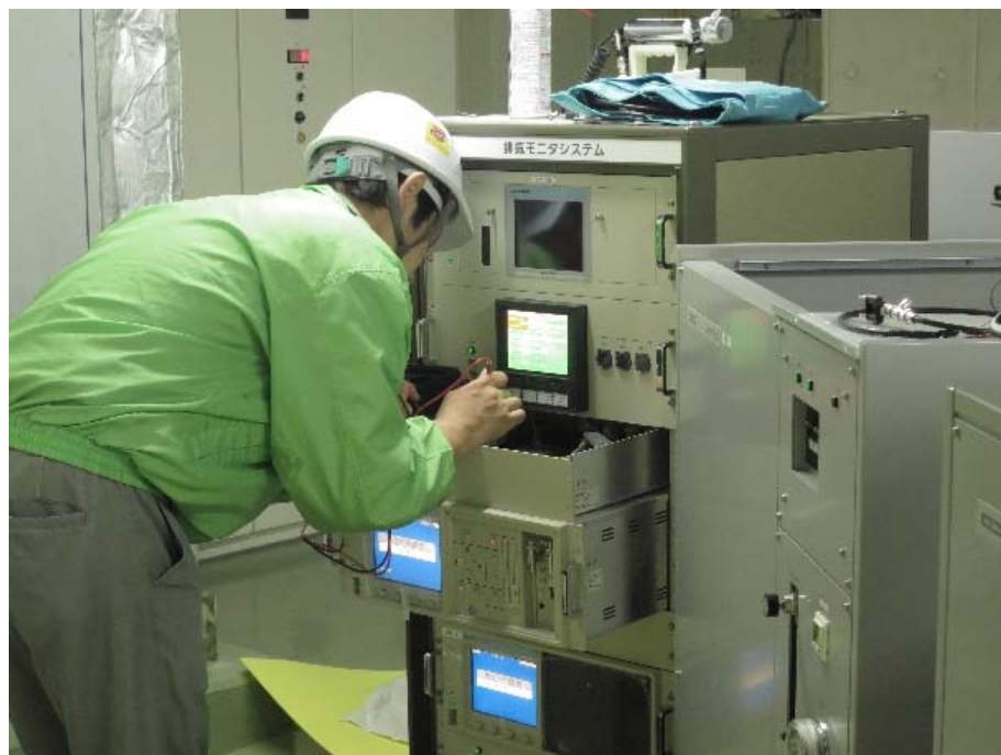
排気塔ガスモニタの供給電圧測定の様子
