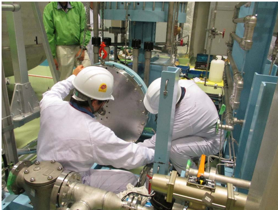
圧縮機保守点検の様子
