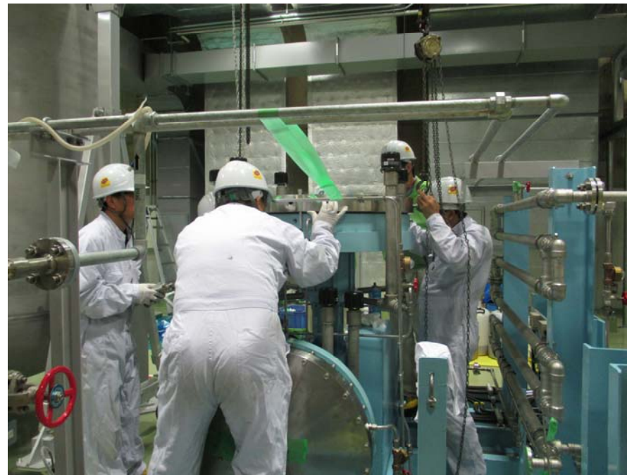
圧縮機上部の取付作業の様子
