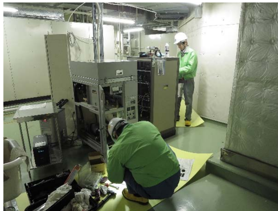
排気塔ダストモニタの分解点検の様子
