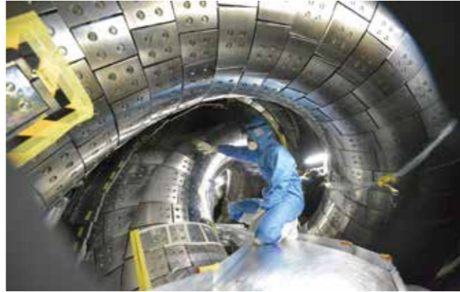
真空容器内での点検作業風景（12月8日撮影）
