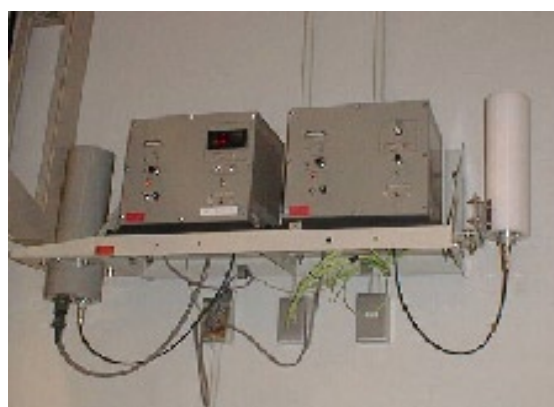
図3-3-4 本体実験棟内の放射線測定器 (写真)
