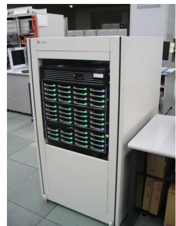
導入したNASサーバ写真
