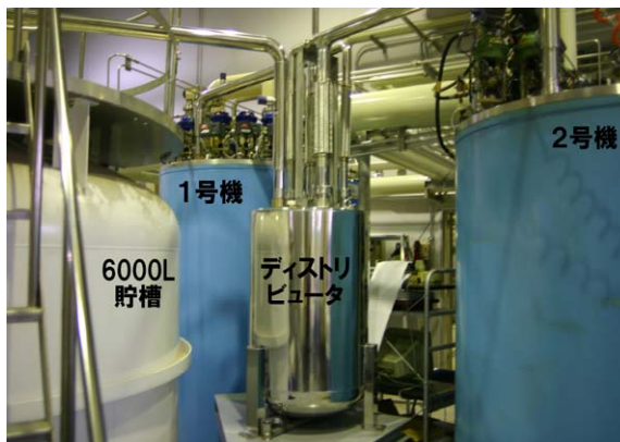
図 2：液化機、貯槽及びディストリビュータ
