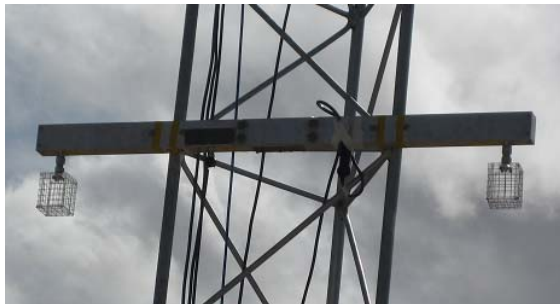
写真2. タワーへ設置されたセンサー
