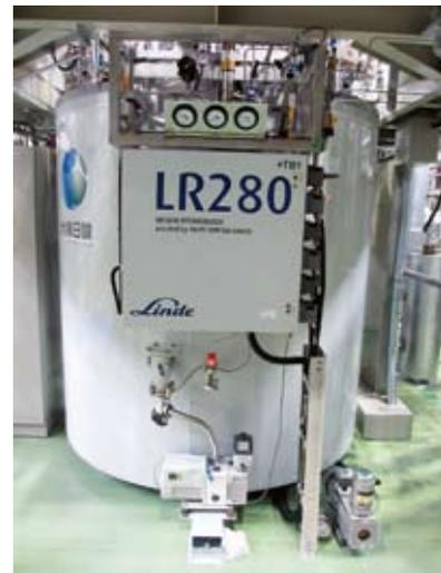
図2 温度可変ヘリウム液化冷凍機
