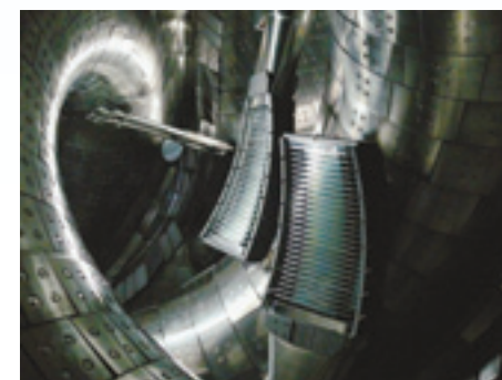
図2 トロイダル方向に2本1対からなるHASアンテナ。各々のアンテナは上下ポートから高周波電力を供給しており、プラズマの径方向に動かすことができます。アンテナとプラズマの近接する場所ではカーボンプロテクターと呼ばれる炭素製の保護板(アンテナを四方から囲っている板)が取り付けられており、アンテナをプラズマから保護しています。
