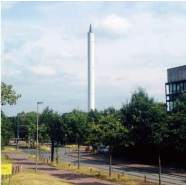
図2 ブレーメン大学ZARMにおける落下塔の外観。この塔内を丸ごと真空にした中に実験カプセルを落下させて実験する。
