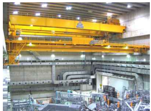
図2. 2. 6. 1 大型ヘリカル実験棟 250トンクレーン
