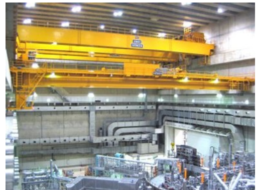
図2. 2. 6-1 大型ヘリカル実験棟 250トンクレーン
