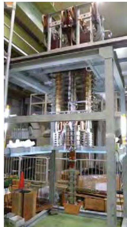
図 4.4.1-2 1回目 ITER-TF 接続部の取付
