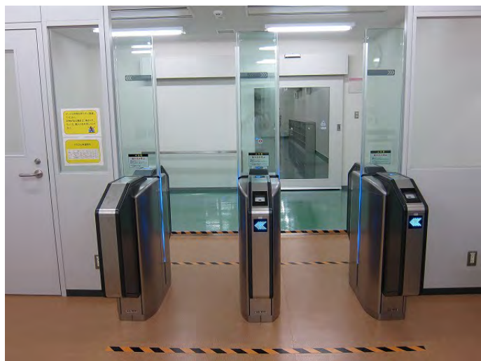
図 3.5.1-5 入退管理室に設置された入退ゲート
