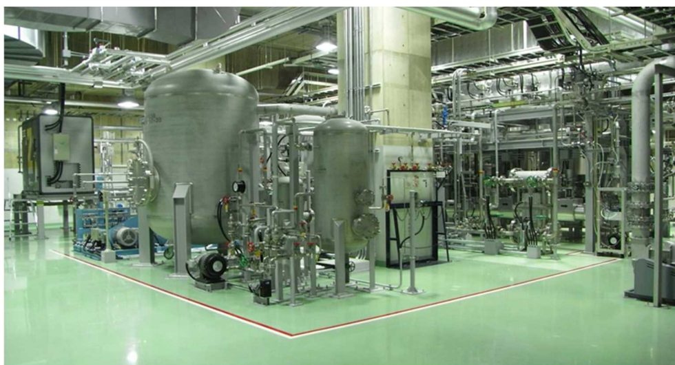
図 4.19 トリチウムを含む全ての水素同位体ガスを酸化して、水の形態で回収する『排気ガス処理システム』
