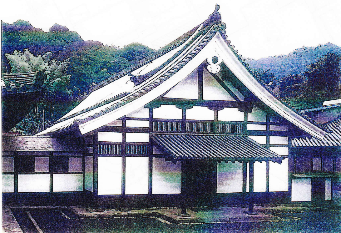
竣工 西正側面全影
