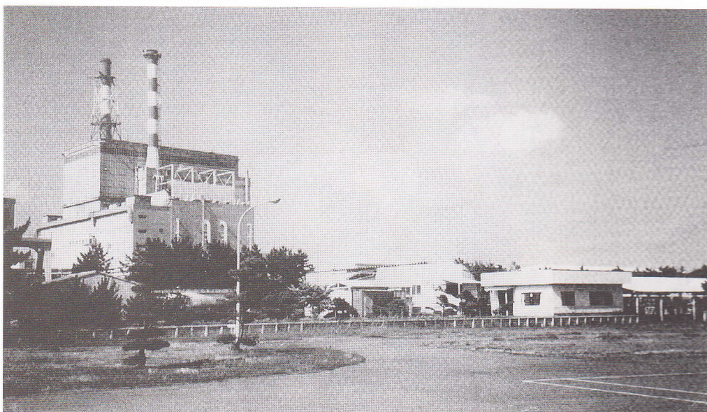
東海事業所近景(左が原子力東海発電所)
