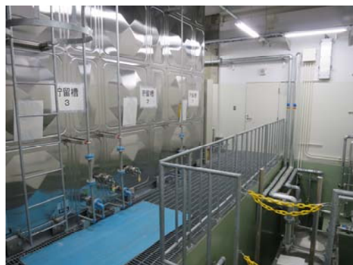
排水用貯留槽
