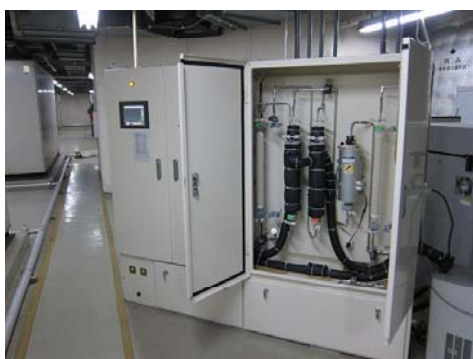
排気塔トリチウム捕集装置
