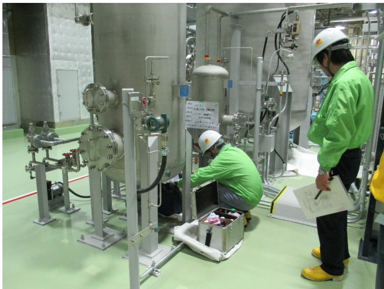
圧力容器点検の様子
