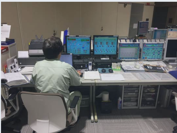
制御室における機器の監視
