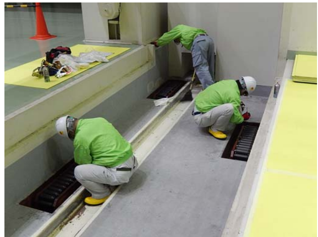
遮蔽扉点検・整備の様子2
