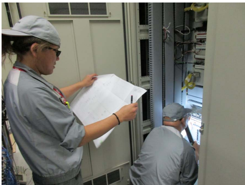
本体監視パネル点検の様子
