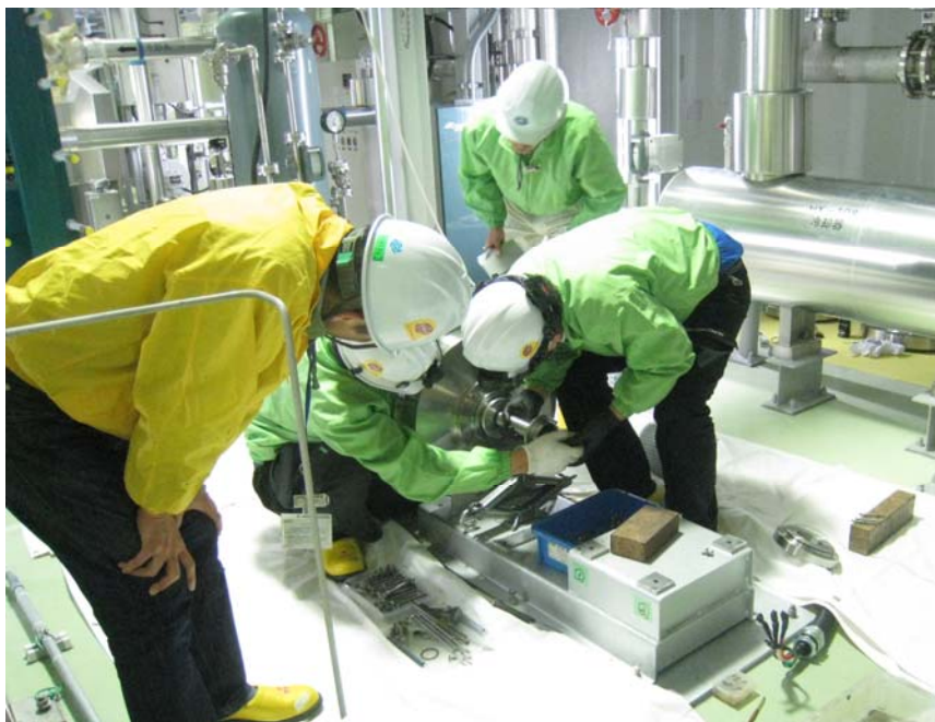
送風機保守点検の様子
