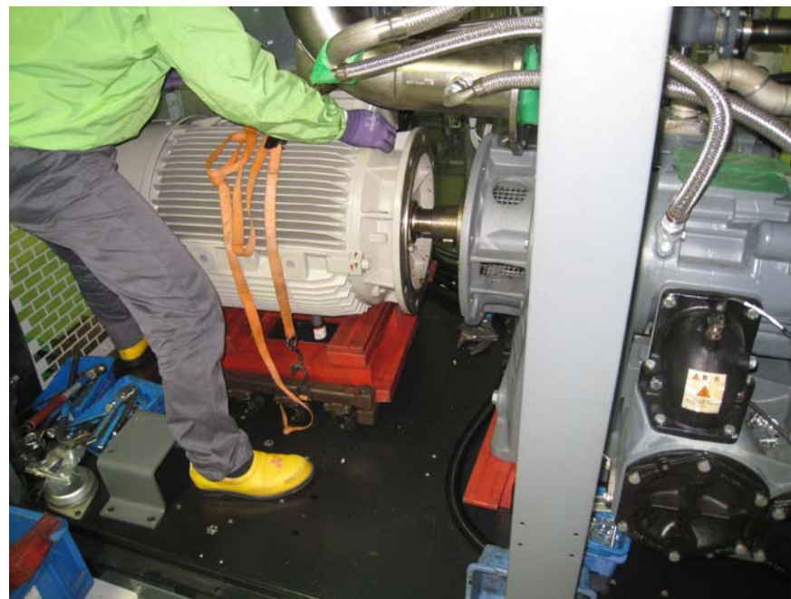
圧縮機保守点検の様子
