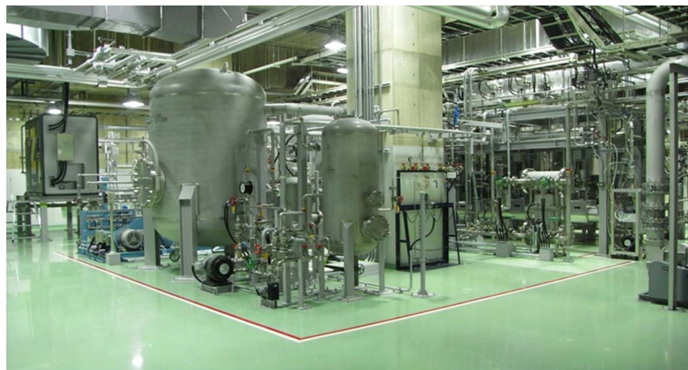
排気ガス処理システム
