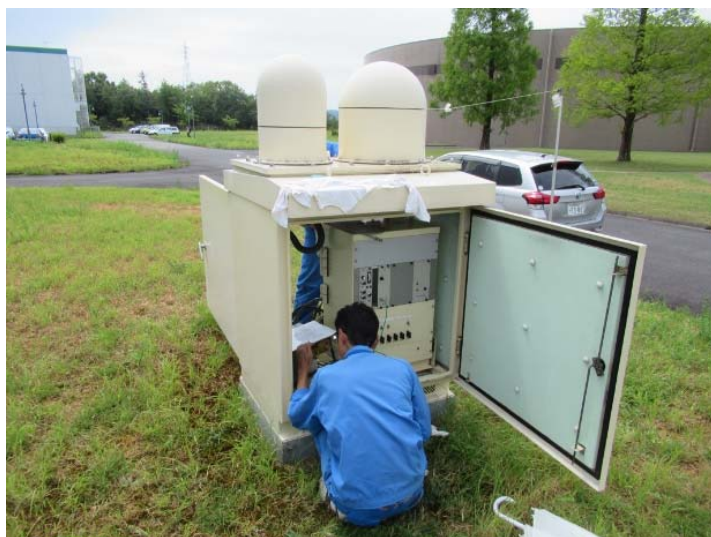
IBポストの点検の様子
