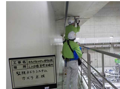
本体室内ITVカメラ 点検の様子
