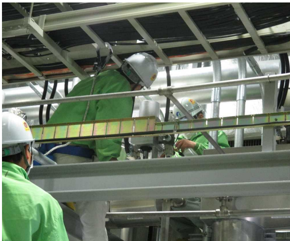
圧縮空気動作弁点検の様子
