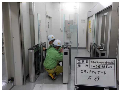
本体室入口ゲート 点検の様子
