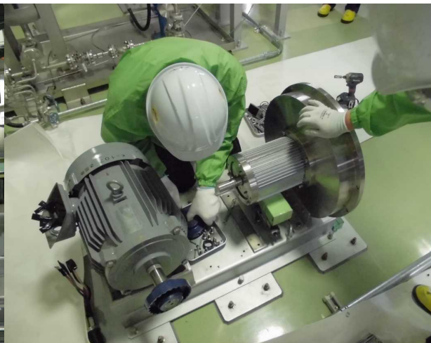
送風機保守点検の様子
