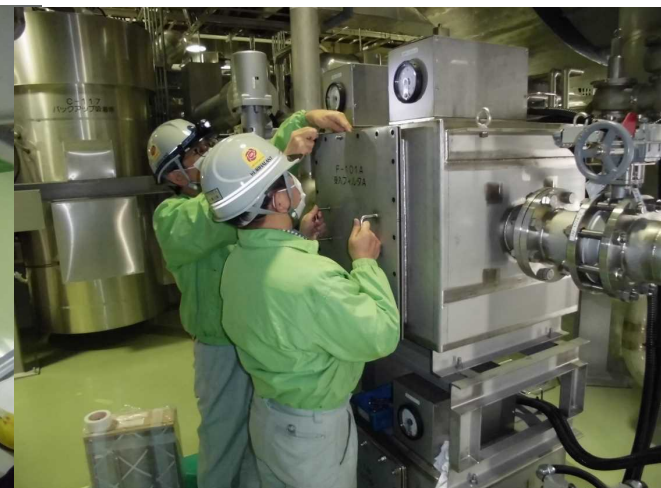
フィルター交換の様子 32/38
