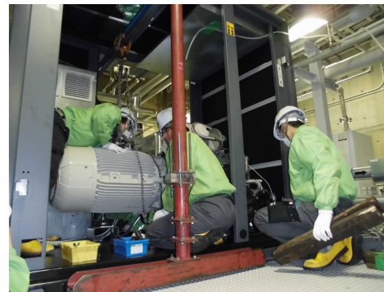
圧縮機保守点検の様子
