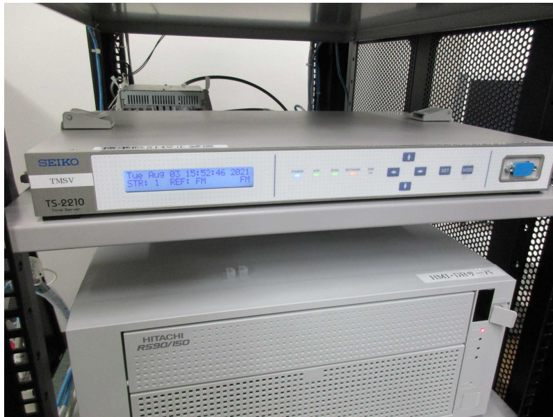
交換前の標準時刻校正装置 と中央制御サーバ
