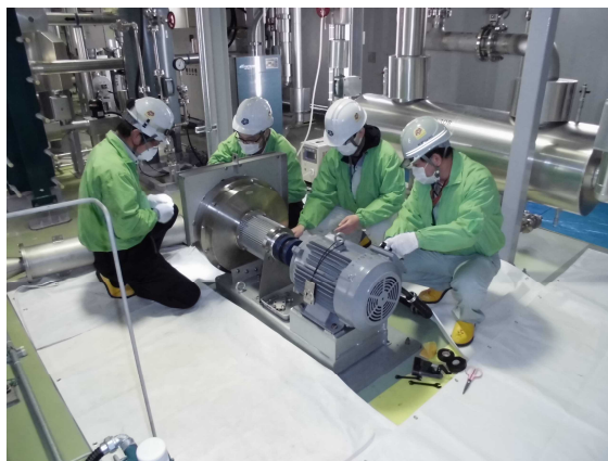
送風機保守点検の様子
