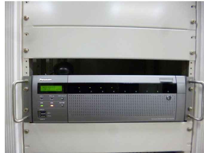
交換したHDDレコーダー
