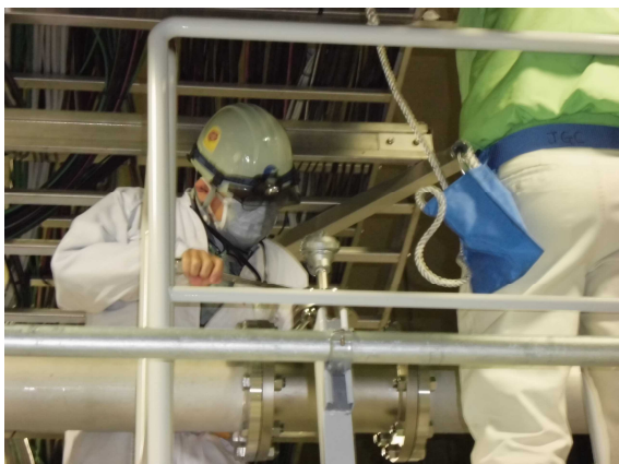
熱線式流量計保守点検の様子
