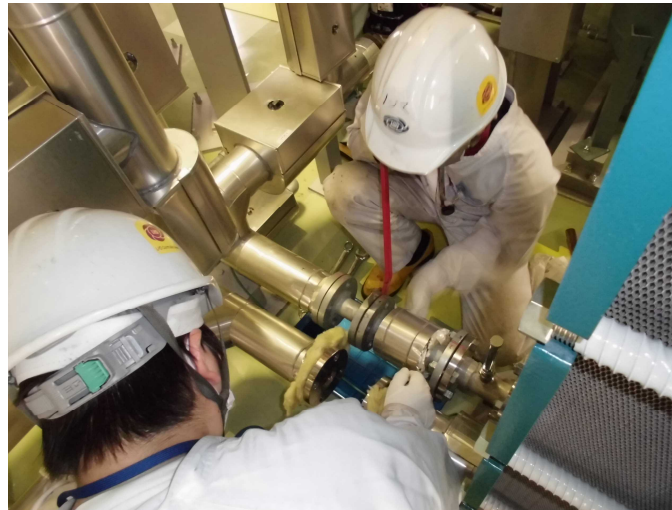
ストレーナー交換作業の様子
