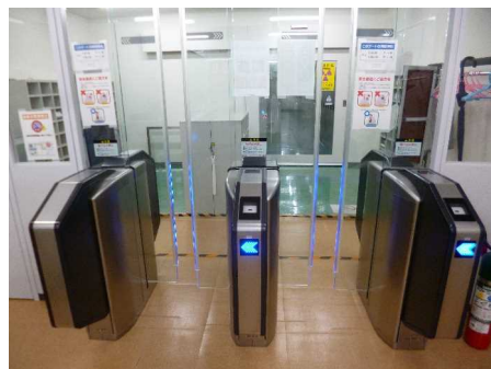
更新前の管理区域入口ゲート
