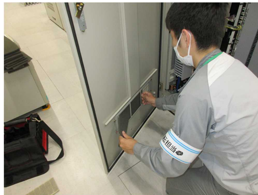
制御盤フィルタ交換の様子
