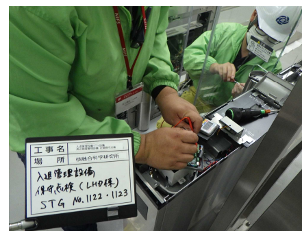
本体室入口ゲート点検の様子
