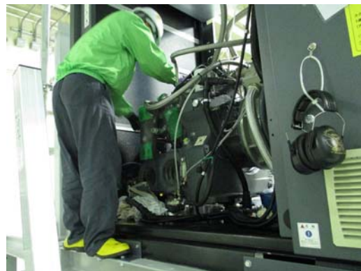
圧縮機保守点検の様子
