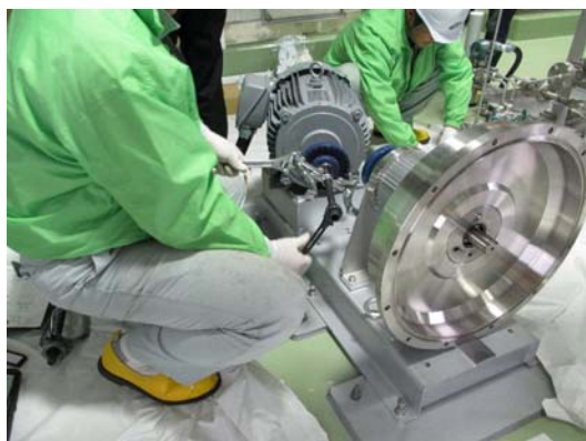
送風機保守点検の様子
