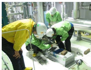
定期的な消耗部品の交換、保守点検後の運転状態の確認(95%以上の除去性能)
