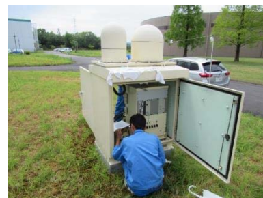
モニタリングポストの点検の様子 全機器の健全性を確認
