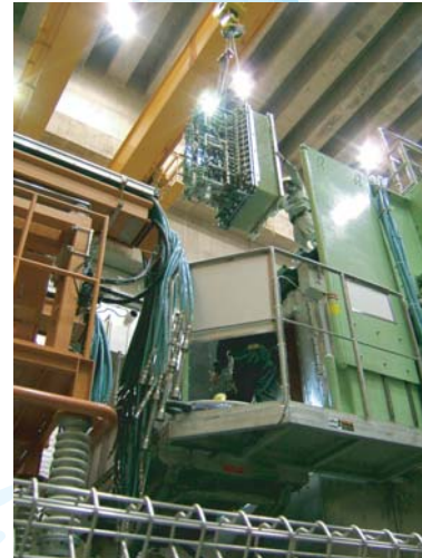
負イオンビーム源をNBI装置に取り付けるところ。LHDプラズマを高温度・高密度にするために欠かせない大型の加熱装置なので、作業は慎重に、そして安全に行います。
