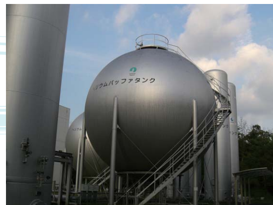
ヘリウムは貴重な資源なので、回収・循環して使います。敷地内にはヘリウムを貯蔵するタンクが並んでいます。
