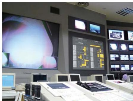
大型スクリーンの周りには、地震計、火災報知器などの警報機が並び、もし警報が鳴ったら自動的に直ちに実験が停止します。
