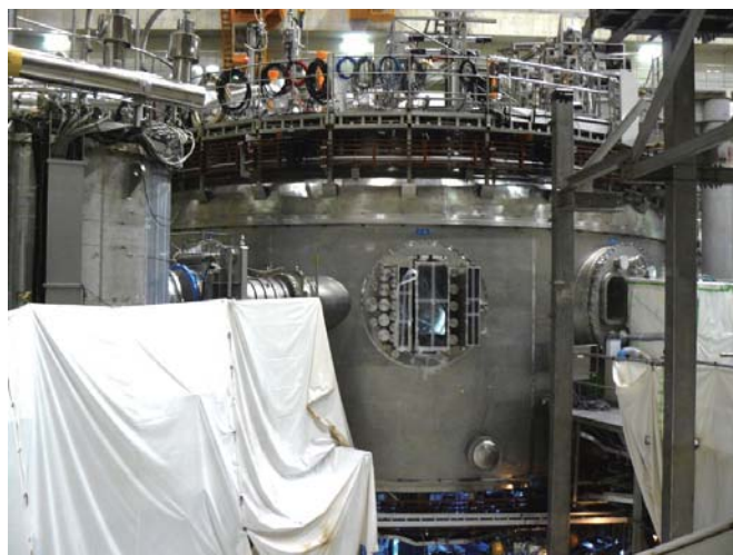
LHD周辺の工事の様子。ポートに付いていた計測器を取り外したため、開口から中が少し見えます。
