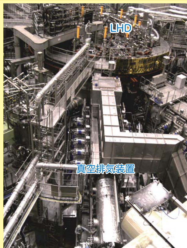
LHD（奥）と手前にのびた真空排気装置
