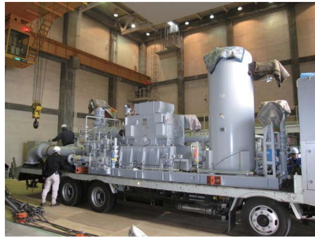
増設する圧縮機の搬入の様子
