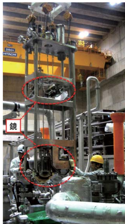
きれいに掃除した鏡をLHDに取り付けている様子
