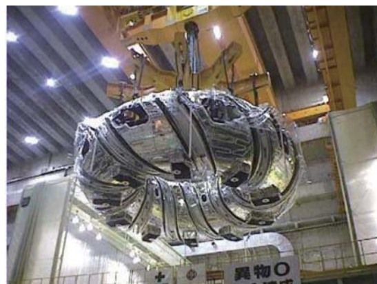
LHD建設時、ヘリカルコイルを吊り上げている2台の250トンクレーン
