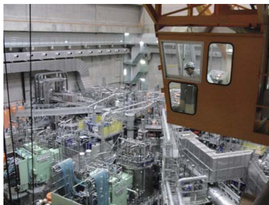
LHDを見渡しながらかレーンを操縦します
