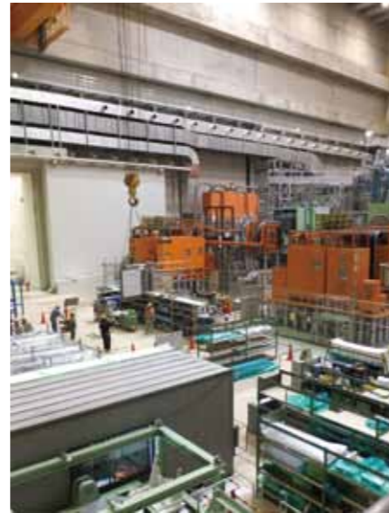
LHD (写真奥) とメンテナンスのための資材置き場 (手前)
