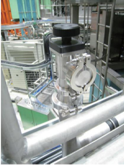
図 5. 作業用排気配管取り合いバルブ
