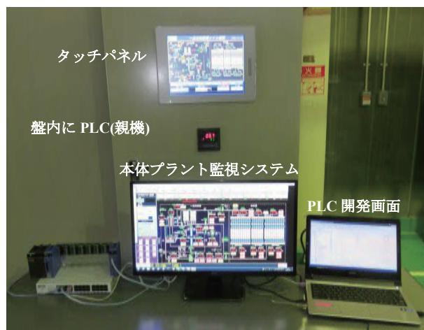
図 4 入出力試験状況
