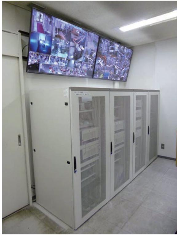
図 2. 大型ヘリカル実験棟の ITV 機器
