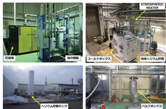
図 5. IFMIF 冷凍設備機器の外観図
