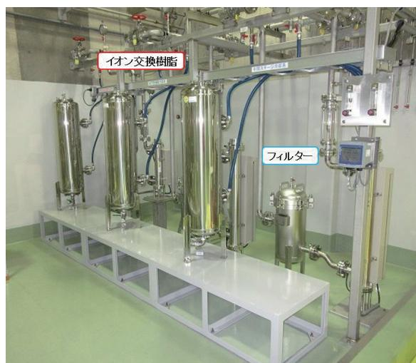
図3 移設後の純化設備
