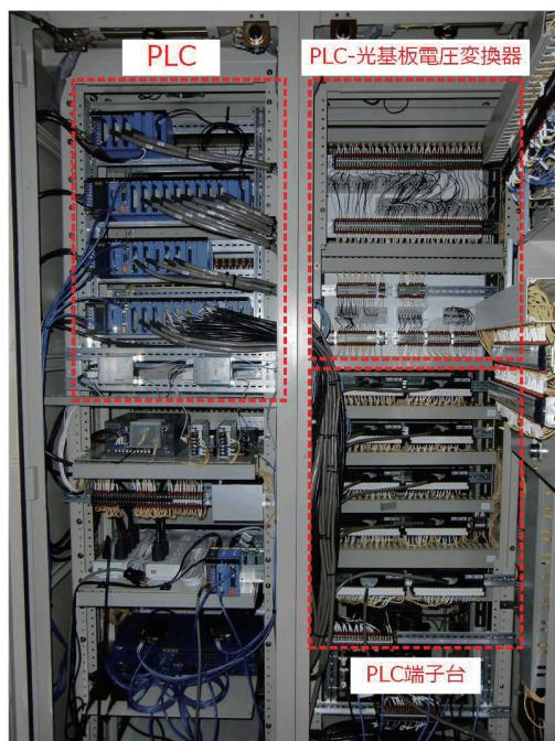
図 4. CP2 盤内機器（改造後）
