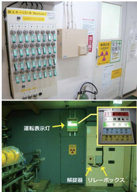
図 4. 下流側パーソナルキーシステムと下流側入口扉
