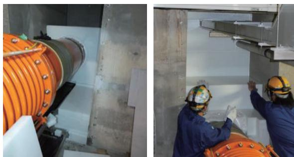
図 10. ポリエチレン板での閉止作業
