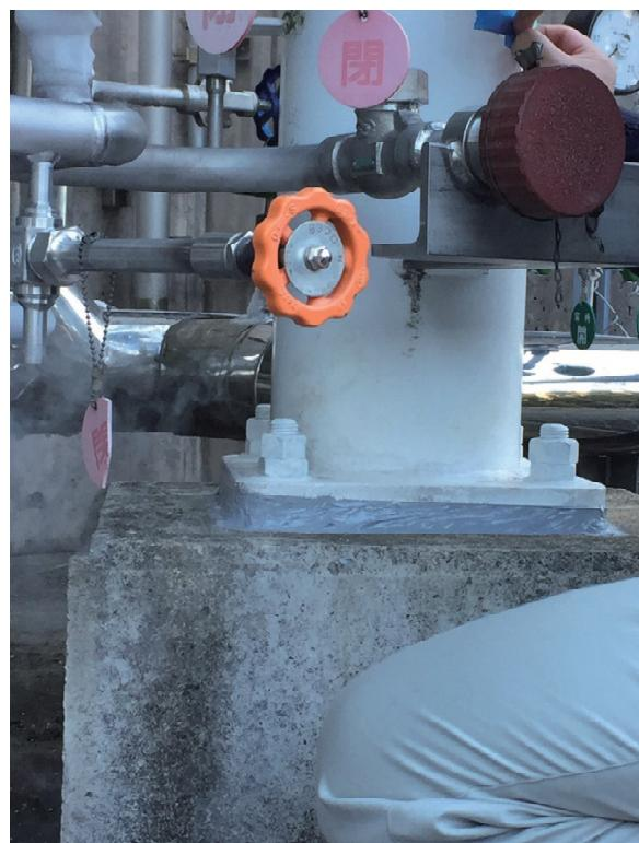
図4. 液化窒素CEの脚部の隙間にシリコンコーティング材を充填した様子。
