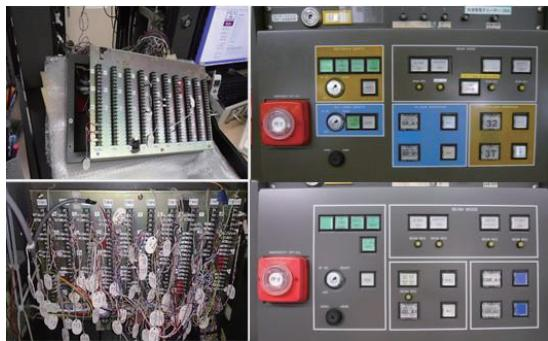
図 6. 入射器運転操作パネルの更新前後
