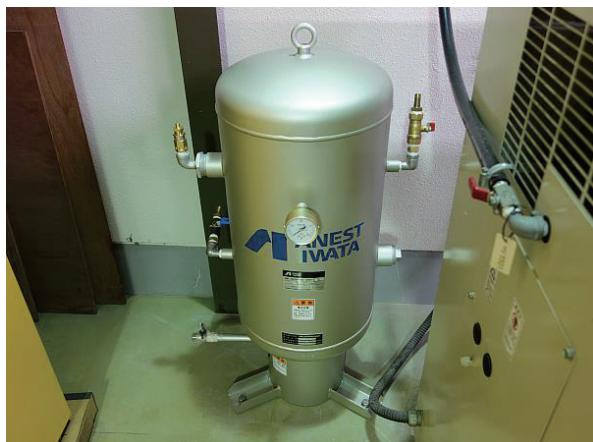
図6. 新設したバッファタンク
