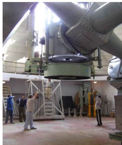
写真4. 主鏡セルの取り外し
