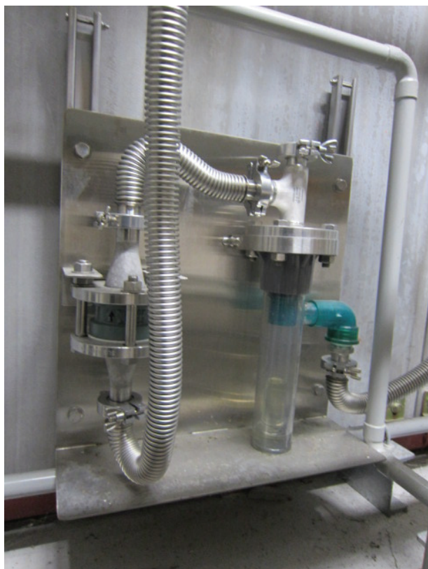
図1 油封入式安全器
