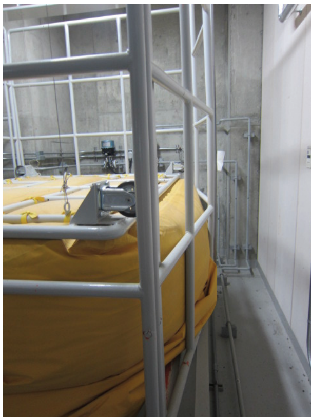
図2 外側に大きく湾曲した鉄棒
