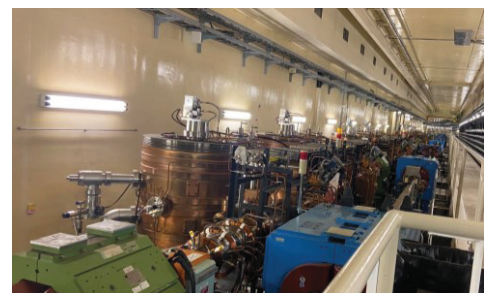
図 2 ARES 空洞が多数並ぶ D7 直線部
