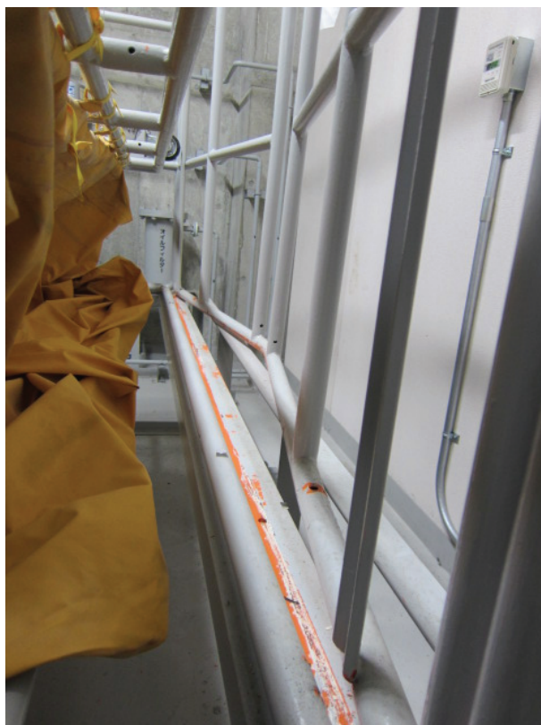
図3 鉄棒湾曲のため、棒ごと固定ネジが破断
