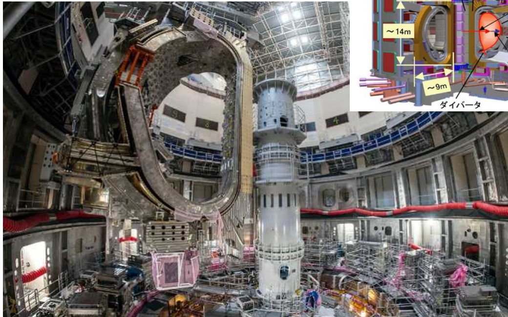
図 1 ITER は南仏のエキサン・プロバンス近郊サン・ポール・レ・デュランに建設中である。写真は外径約 30m のクライオスタットとよばれる断熱容器の中で超電導 TF コイル 2 個と真空容器の 1 セクターを 1 セットとして吊り下げて組み立てが開始された ITER。
